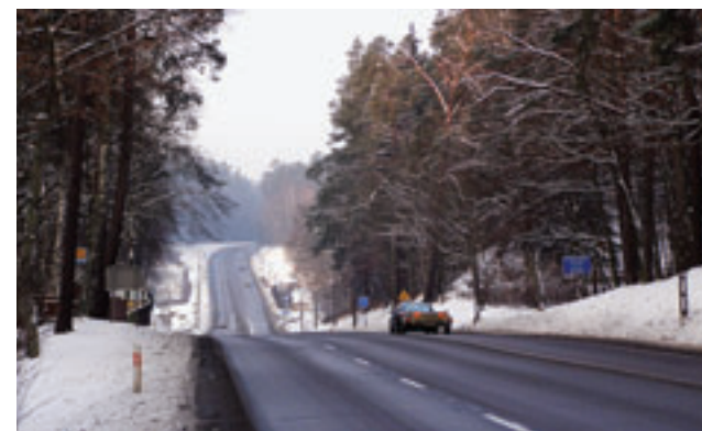
23 firmy i konsorcja chcą budować ponad 9-kilometrowy odcinek drogi ekspresowej S-7 od Miłomłyna do węzła Ostróda Północ Fot. Marcin Tchórz
